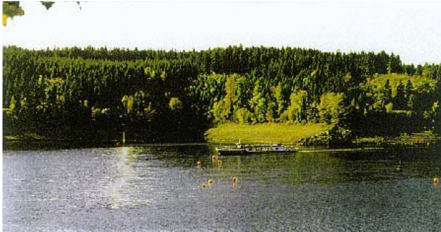
Blasenschleier an der Talsperre Bleiloch
