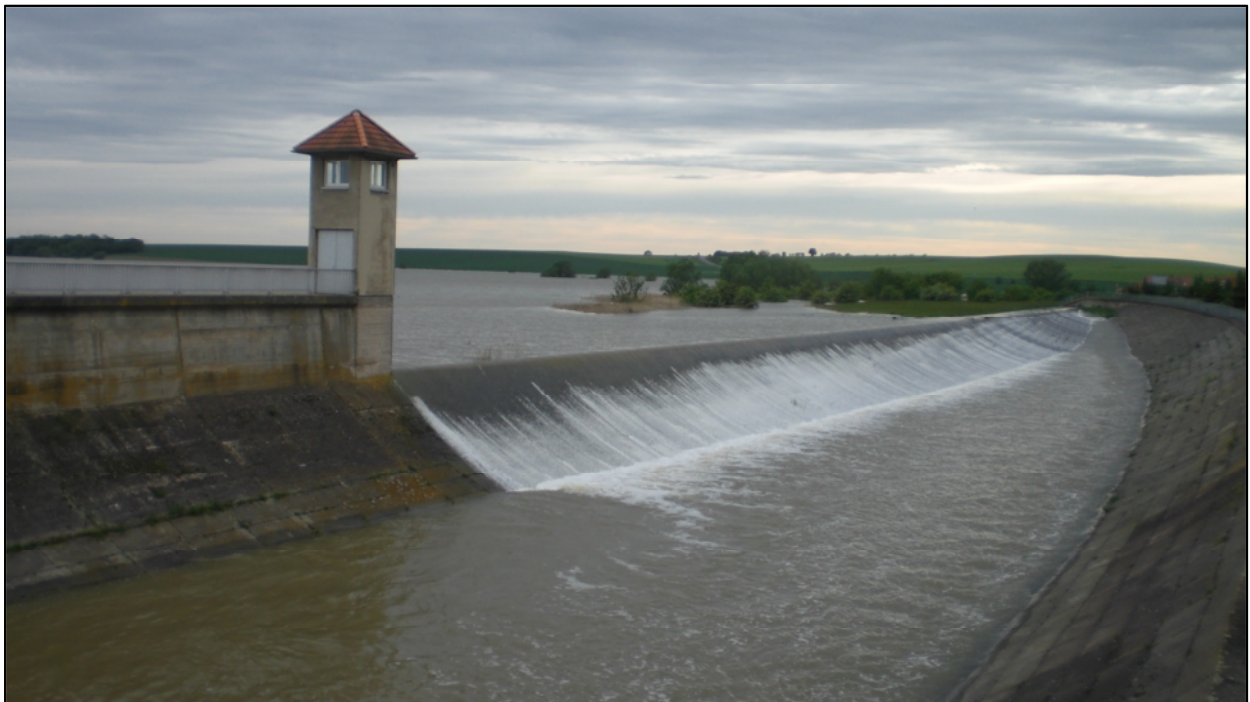
HRB Straußfurt mit aktiver Hochwasserentlastung (Photo: TLUG, Juni 2013)
