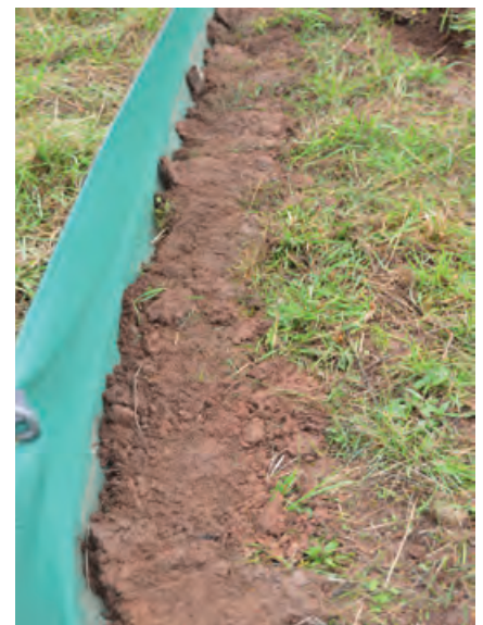
Abb. 2: Die umgeschlagene Zaununterseite mit festgetretener Erde bietet einen guten Unterwanderungsschutz sowie eine ebene Lauffläche. (Aufn. E. HEROLD 20.10.2016)
