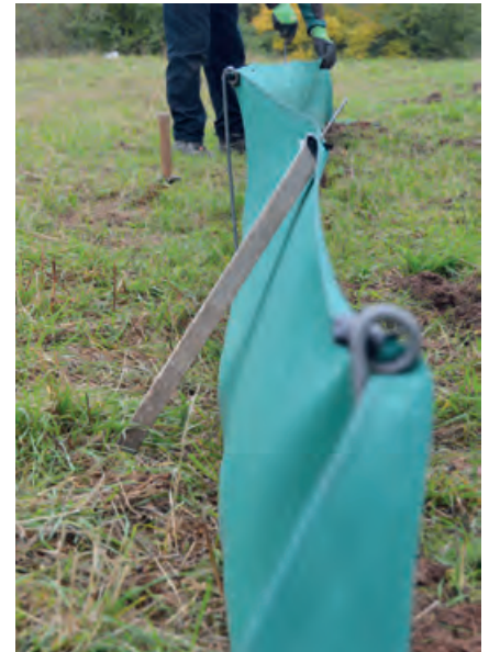
Abb. 1: Selbst gefertigte Holzpfähle schrägen den Zaun an. Somit wird den Amphibien ein Überklettern der Anlage deutlich erschwert. (Aufn. E. HEROLD 20.10.2016)
