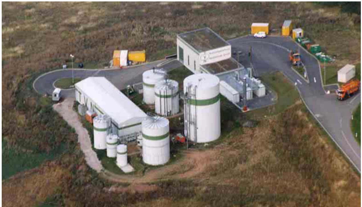
Abbildung 3: Anlage zur Bioabfallvergärung auf der Deponie Nentzelsrode
