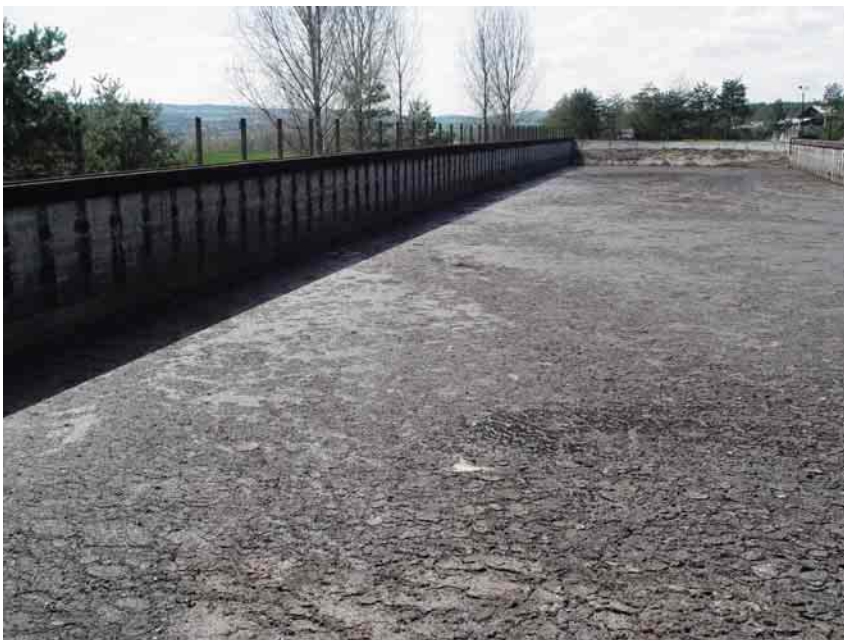
Abbildung 11: Lagerung von Biogasgülle in einer Lagune
